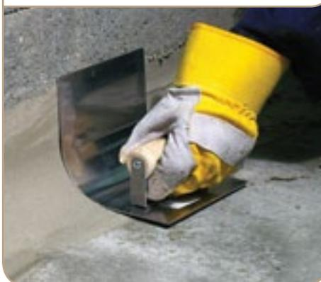
Mortier époxy résistant à l'usure pour la formation de plinthes arrondies.
