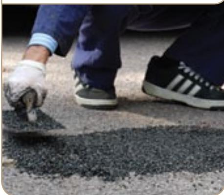
Mortier haute résistance à base de résine époxy pour des réparations difficiles sur des sols en asphalte.
