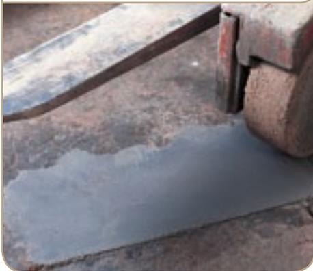
Mortier époxy à séchage rapide pour les zones à trafic intense. Durcit en 3 heures à 20°C.
