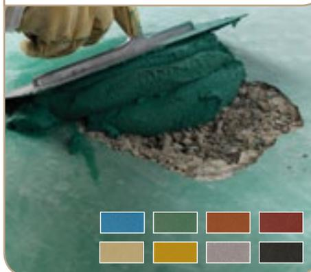
Contient de la résine époxy novolac pour un mortier encore plus résistant aux températures élevées, aux produits chimiques et aux solvants. Disponible en bleu, vert, terracotta, rouge brique, sable, chamois, gris clair et noir.
