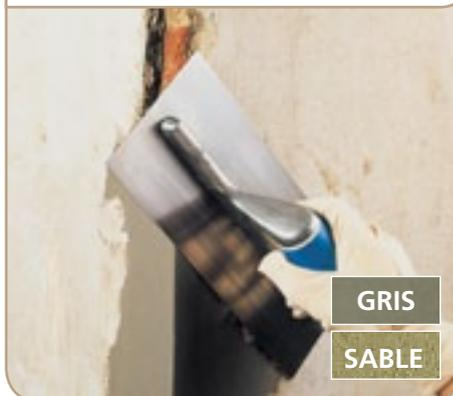
Mortier bicomposant à base de résine époxy et de fillers légers, efficace pour adhérer sur une maçonnerie endommagée.
