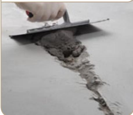
Idéal pour réparer les zones sujettes aux mouvements et aux vibrations.
