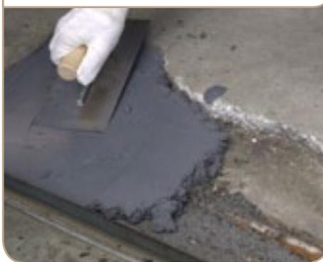
Version froide du Concrex® Gros Trou, spécialement conçue pour combler les trous profonds à basse température.
