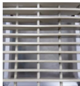
Le plancher en caillebotis permet de visualiser la présence de personnel au-dessus ou en-dessous de la trappe
