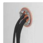
Percement pour passage de câbles PEXTBALL
