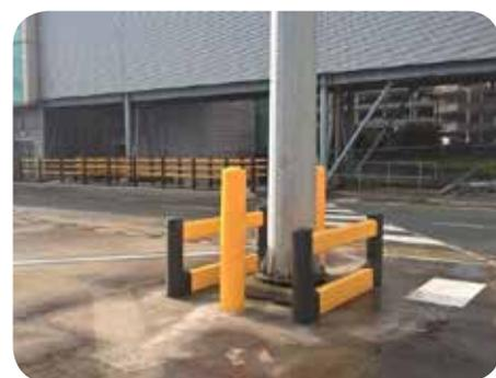
Les poteaux en PEHD dévient et transfèrent l'énergie de l'impact dans le corps absorbant
