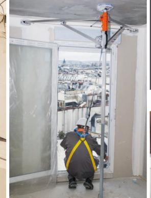
LE SYSTÈME D'ANCRAGE MOBILE SYAM est un point d'ancrage transportable qui permet de sécuriser les interventions au bord du vide.
